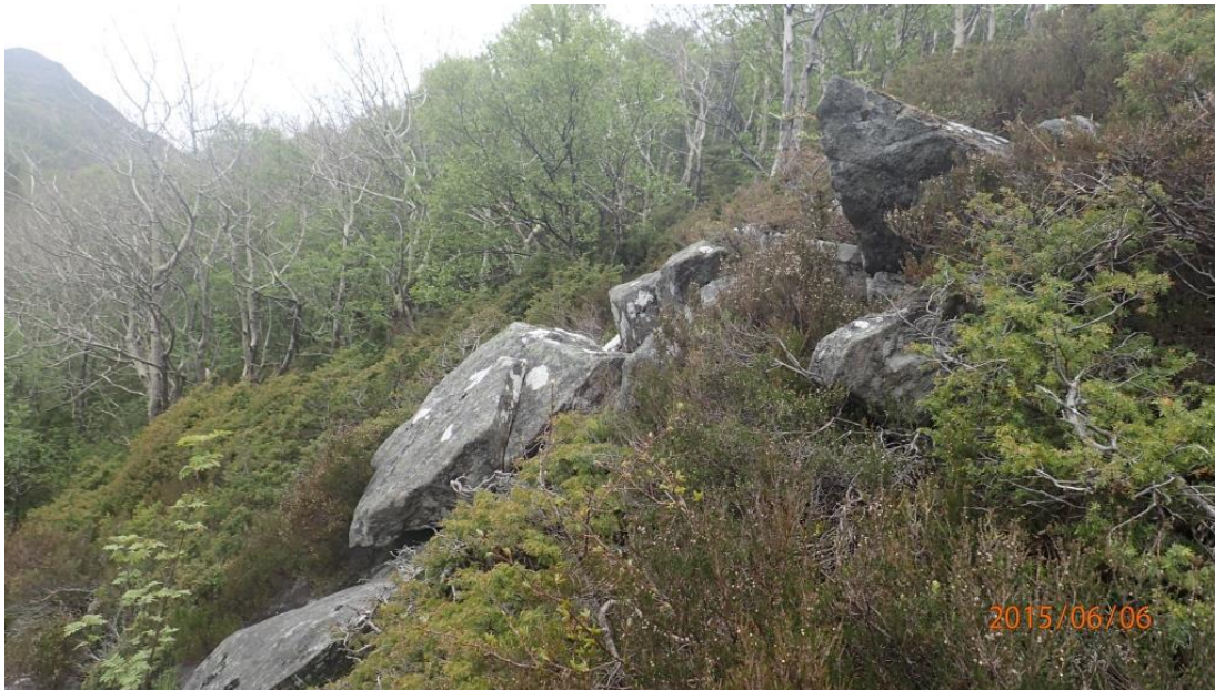
Figur 15 potensielle utspringsblokker i pkt. 1 fig. 14 (foto Georg Johansen)
