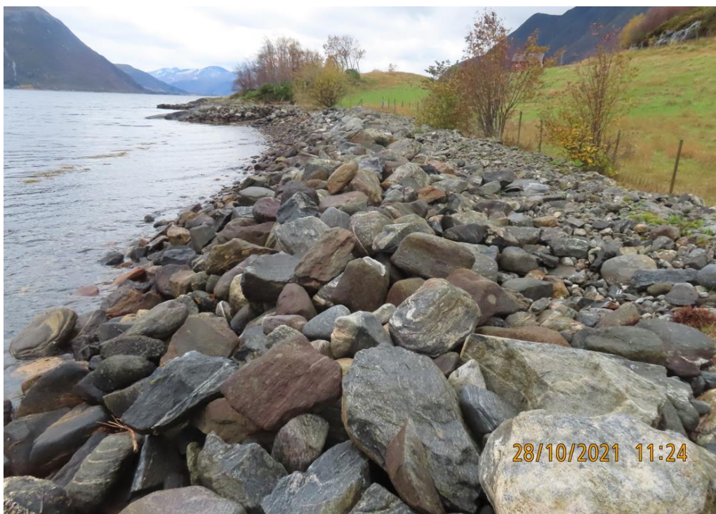
Figur 3 Steinfylling langs flo-målet i strandsonen. Rorbuene vil etableres på oppsiden av fyllingen.
