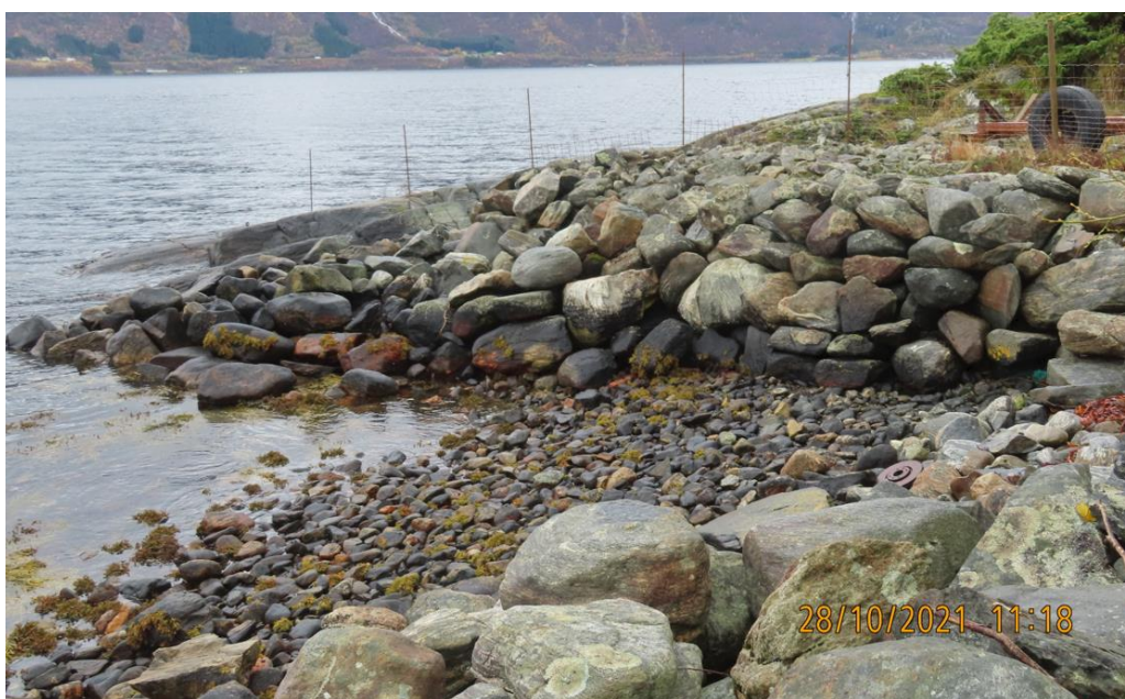
Figur 4 Området hvor molo vil forankres i fast fjell i fortsettelsen av steinfylling.
