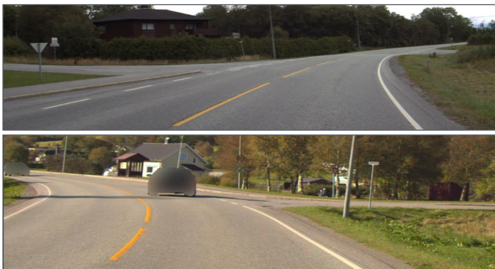
Figur 6. Fv. 61 kryss med kv. Reiten. Retning mot Hareid (øvt), mot Ulstein (nedst). (Vegbilder.atlas.vegvesen.no, sept 2021)
