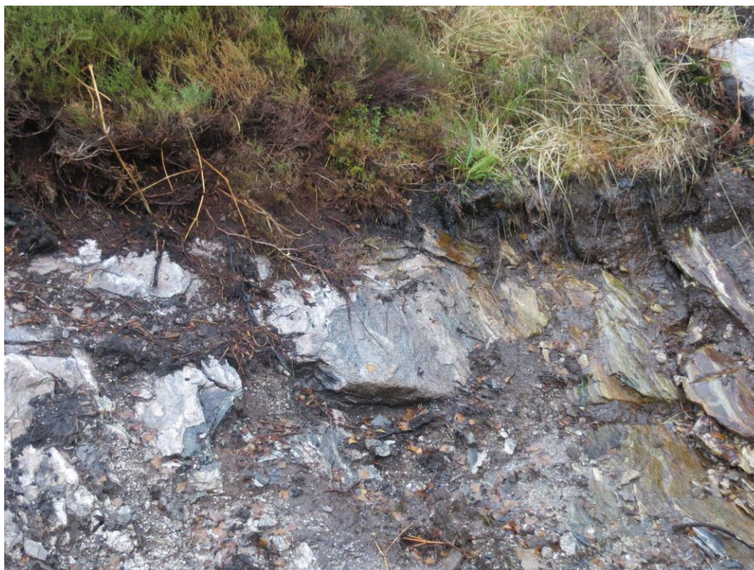
Figur 17 Eksempel fra midtpartiet av planaralet viser tynn humus på fjellet
