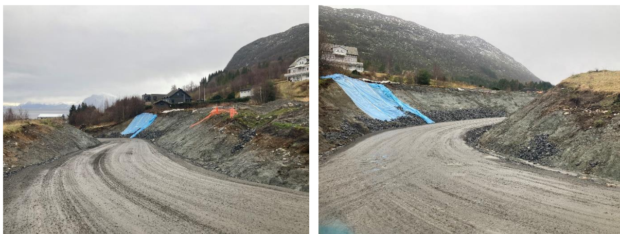
Figur 29 Bilete av mellombels anleggsveg frå synfaring 29.11.24. Foto: Kristina S. Karlsen Norconsult AS
