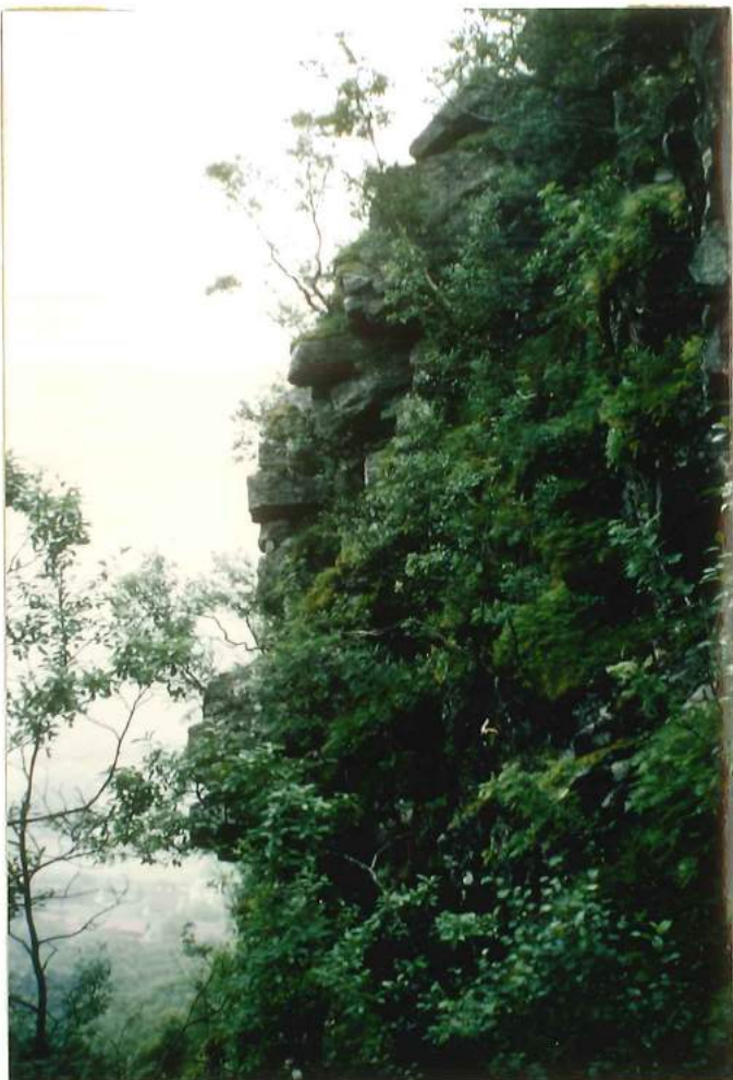
Foto nr.5. Hele skrenten langs Knutenakken er sterkt oppsprukket, vanligvis med tilnærmet horisontale og vertikale avløsningsflater. (Ved profil 7).
