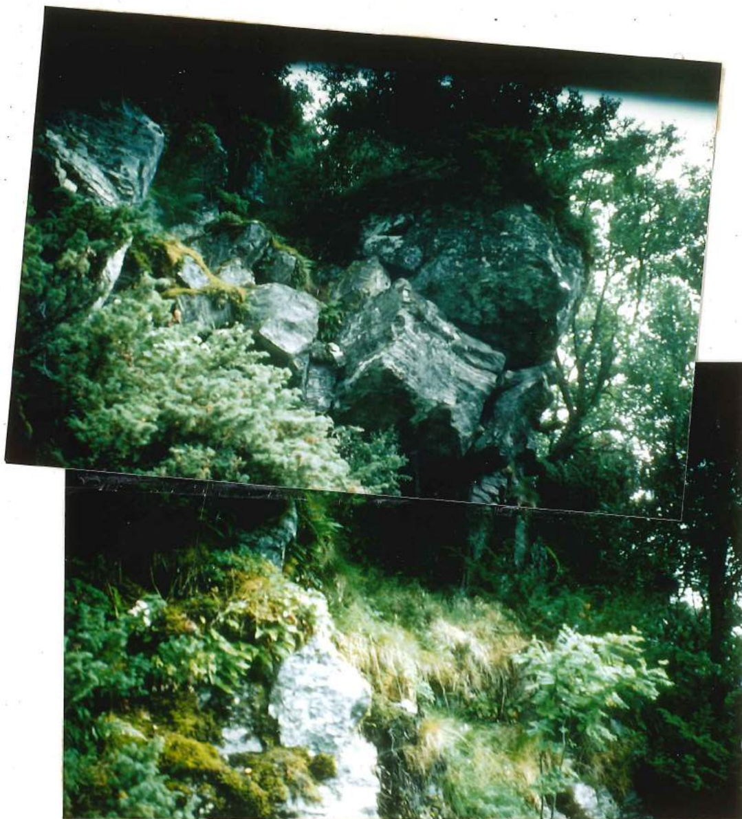
Foto nr.7. Sterkt oppsprukket og utoverhellende skrent. Løsblokker. (Ved profil 5, tegn.001).
