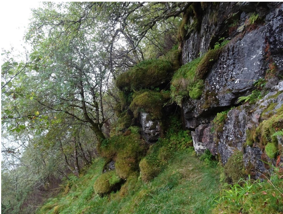
Figur 20: Bilde fra Lokalitet 4 Område B (se vedlagt registreringskart) viser stablede blokker som er avløst. Stabilitet er usikker.
