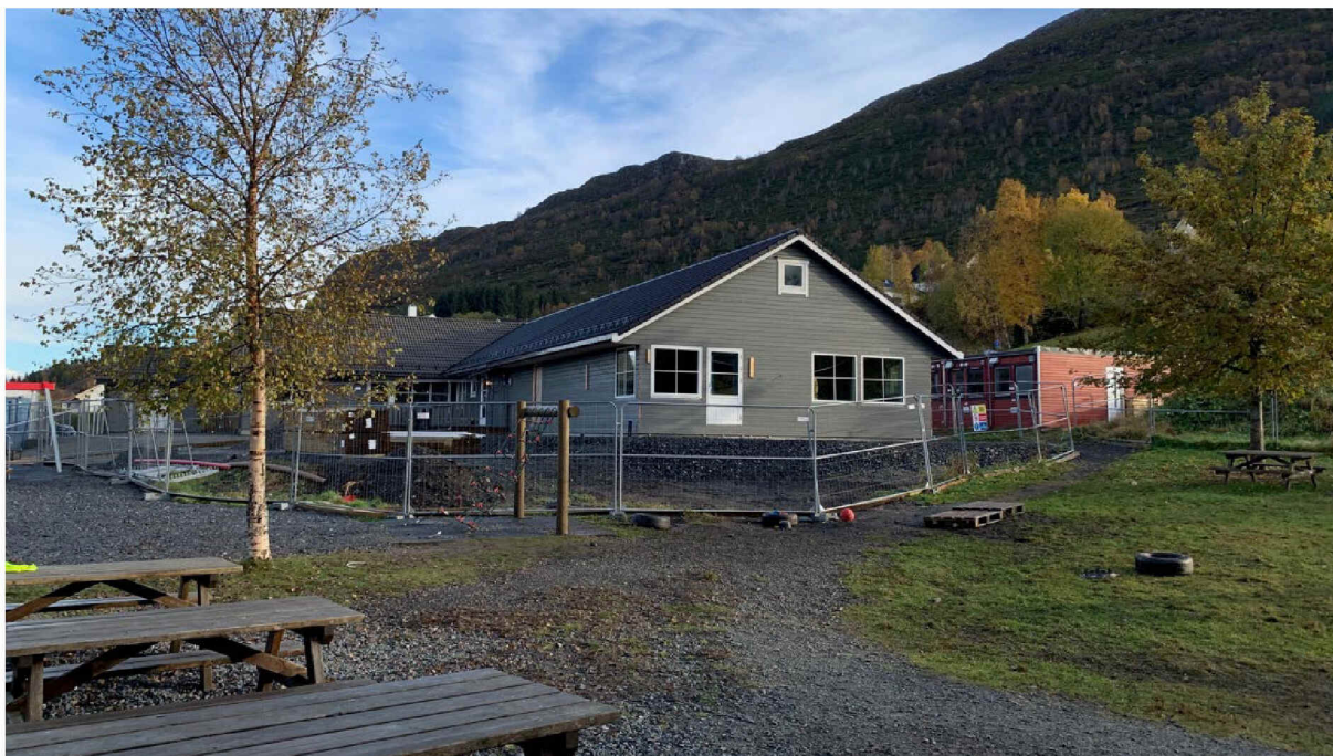
Figur 26 Utviding under oppføring mot vest. Kjelde: Sporstøl arkitekter (oktober 2024)
